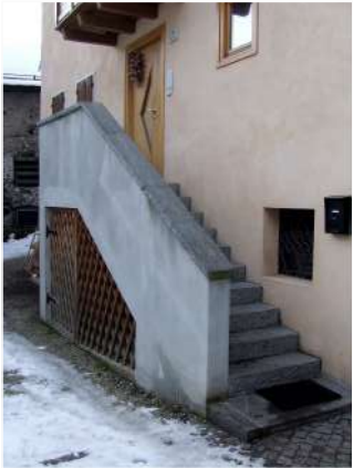
4. Scala in pietra sul fronte Est
