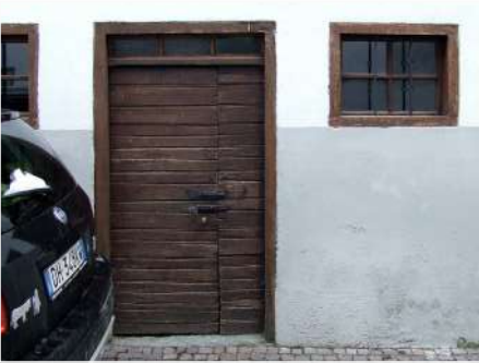
5. Porta di ingresso della stalla in legno
