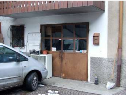
3. Porta del garage al pianterreno
