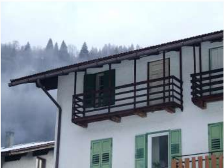
8. Ballatoi sul fronte occidentale
