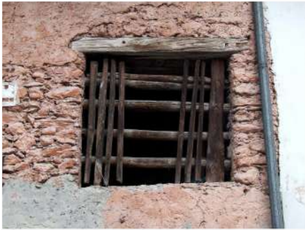
4. Finestra del fienile sul fronte Sud
