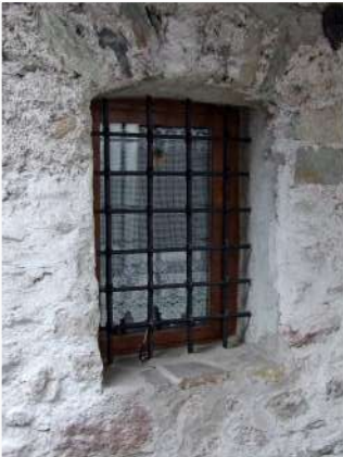
3. Finestra con inferriata in ferro battuto
