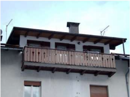
4. Dettaglio abbaino sul fronte meridionale
