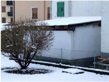
3. Garage esterno, fronte Nord
