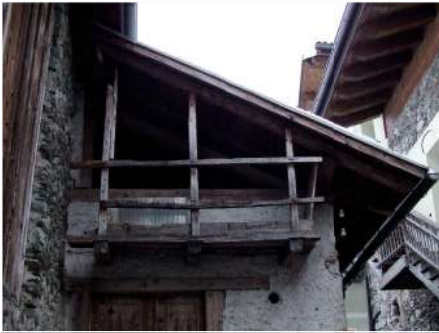
3. Dettaglio del mezzo timpano sul fronte Nord
