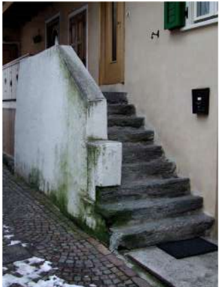
7. Scala in pietra sul fronte Est
