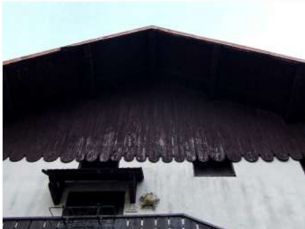
5. Tamponamento del timpano settentrionale
