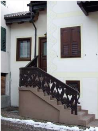
6. Scala di accesso sul fronte Ovest
