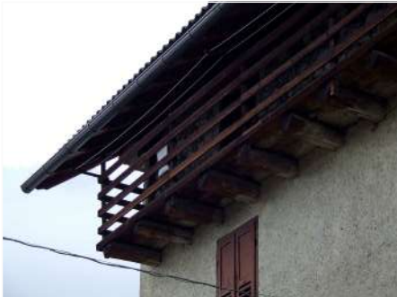
8. Dettaglio del ballatoio sul fronte Sud
