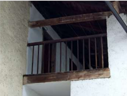
5. Parapetto ligneo tradizionale
