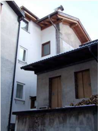
4. Dettaglio del fronte Nord
