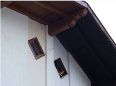
4. Dettaglio dei fori romboidali del vano scala
