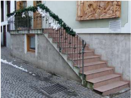
4. Scala di accesso sul fronte Nord
