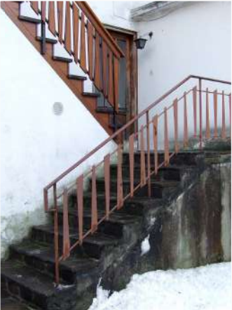
8. Scala in c.a. sul fronte Nord
