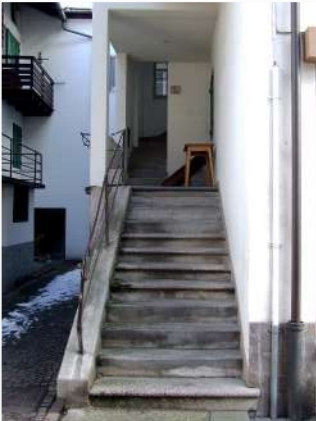
4. Dettaglio scala in c.a. sul fronte Nord
