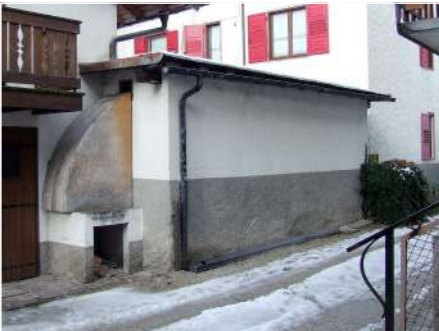
6. Garage esterno, fronte Est
