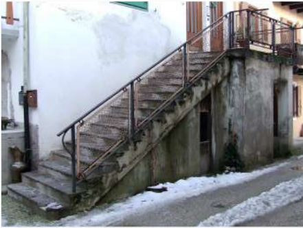
4. Scala esterna in c.a. sul fronte Sud
