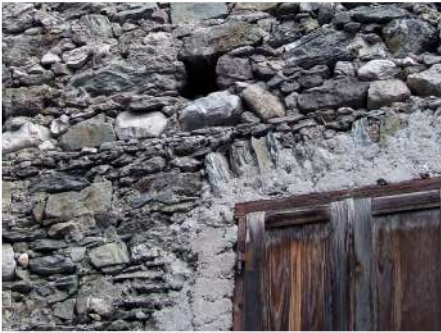
6. Dettaglio della muratura in pietra a vista
