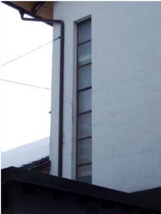
5. Finestra vano scala sul fronte Nord
