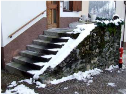
6. Scala esterna in c.a.sul fronte Nord
