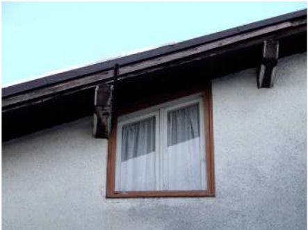
5. Finestra del sottotetto sul fronte Nord
