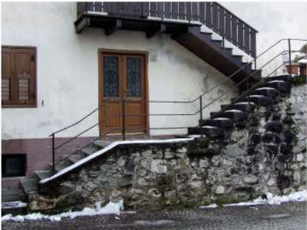
6. Scala esterna sul fronte Nord
