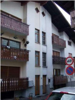
6. Volume aggettante del vano scala
