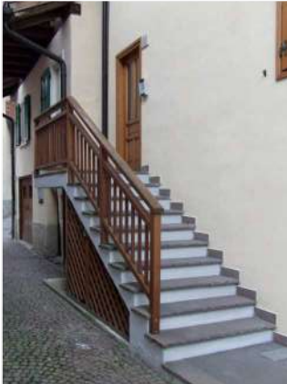
6. Scala esterna sul fronte Nord
