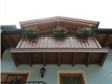
4. Dettaglio dell'abbaino con balcone sul fronte Ovest
