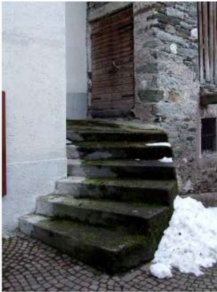
4. Scala in c.a. di accesso al fienile
