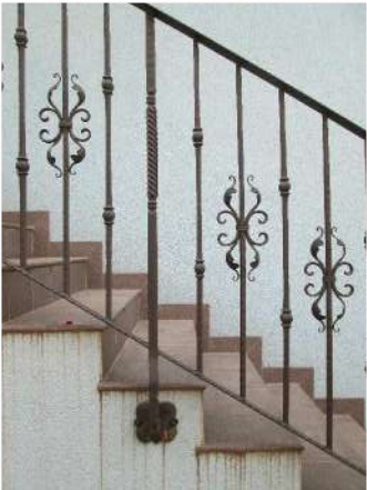
3. Dettaglio del parapetto in ferro battuto
