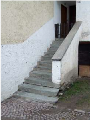
8. Scala in pietra sul fronte Est
