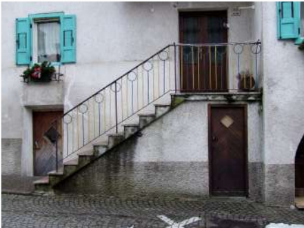
6. Scala in c.a. sul fronte Nord
