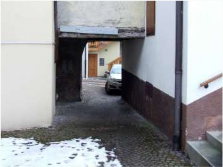
3. Sottopasso direzione Nord-Sud
