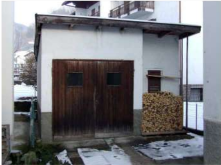
6. Garage esterno, fronte Sud
