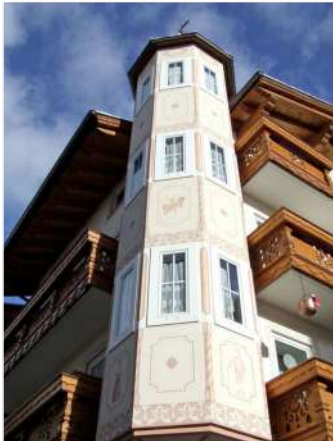
5. Ercher aggettante sul fronte Ovest
