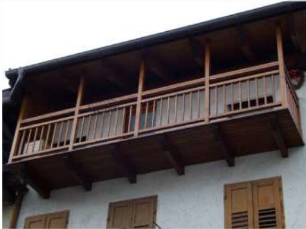
4. Ballatoio sul fronte Sud
