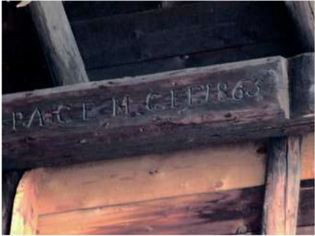
8. Dettaglio della trave di colmo (1863)
