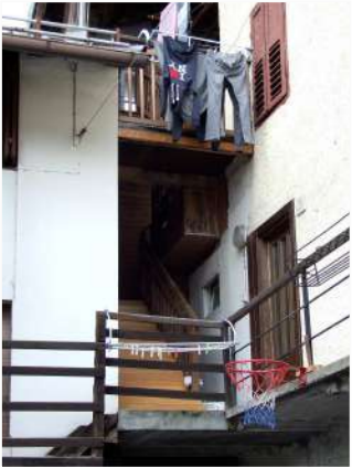
5. Dettaglio dei ballatoi sul fronte Ovest
