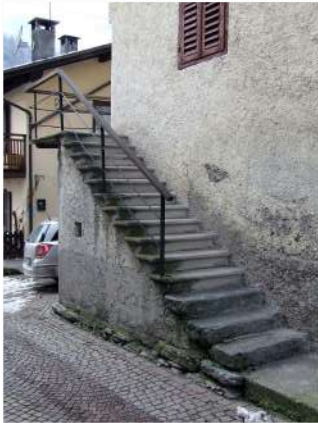
6. Dettaglio della scala sul fronte Sud
