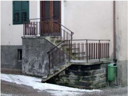
3. Scala di accesso sul fronte Nord
