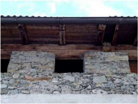
4. Dettaglio fori sottotetto
