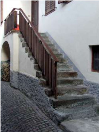
7. Scala in pietra locale sul fronte Ovest
