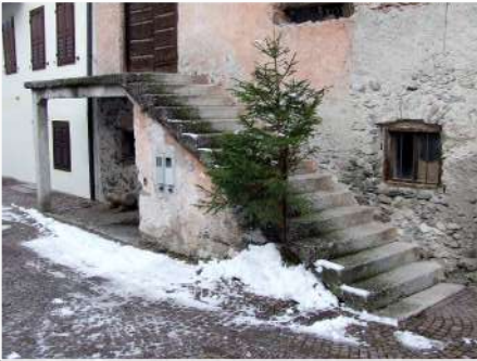
3. Dettaglio scala in c.a. sul fronte Sud
