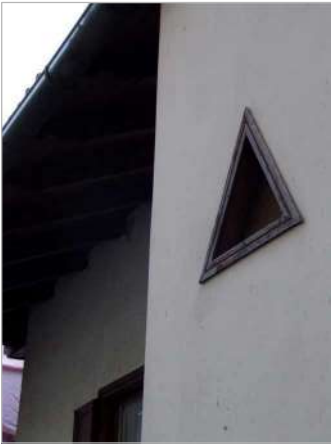
7. Finestra triangolare sul fronte Est
