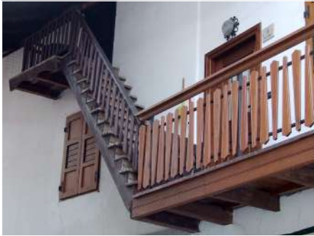
6. Scala esterna in legno sul fronte Est
