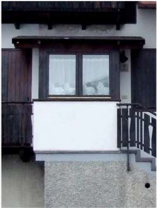
5. Volume aggettante sul fronte Sud
