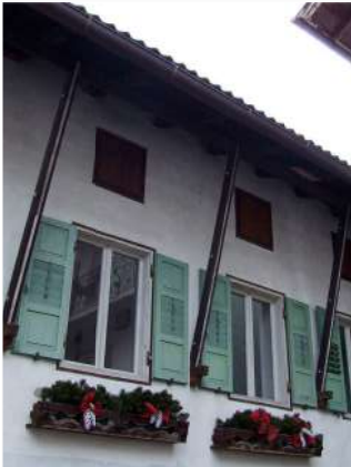
5. Puntoni di sostegno della copertura
