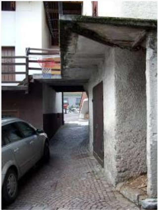
4. Sottopasso direzione Nord-Sud
