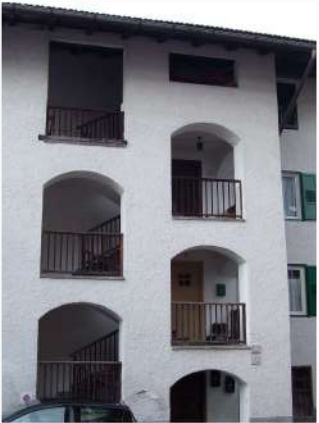
5. Corpo scala esterno con fori ad arco
