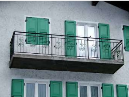
5. Dettaglio parapetti in metallo
