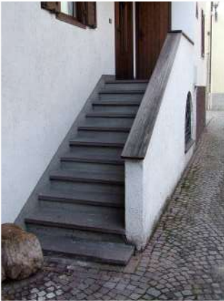
3. Scala esterna sul fronte Est
