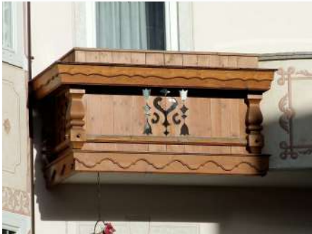
6. Dettaglio dei parapetti lignei
