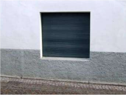
9. Avvolgibile in pvc sul fronte Ovest
