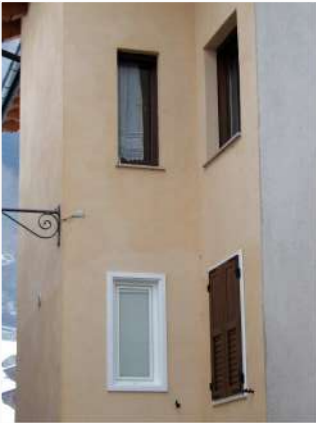
3. Tipologie di serramenti sul fronte Nord
