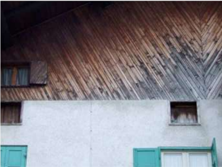
9. Tamponamento ligneo del timpano meridionale
