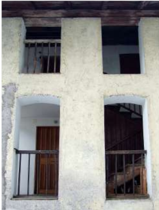
10. Fori ad arco del corpo scala
