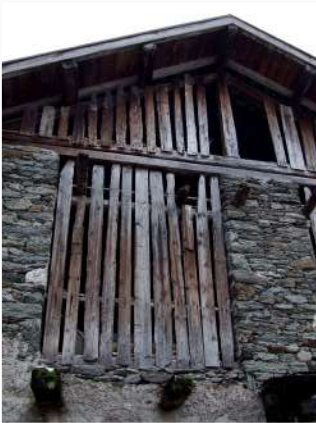
5. Tamponamenti lignei sul fronte Nord
