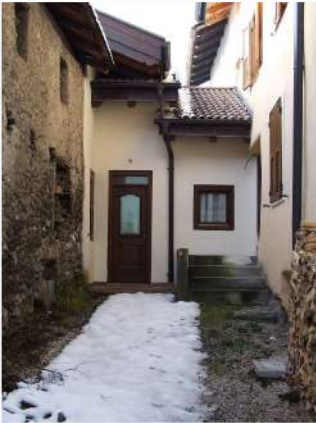
4. Dettaglio dell'accesso ad Est
