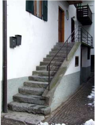
10. Scala in pietra locale sul fronte Sud
