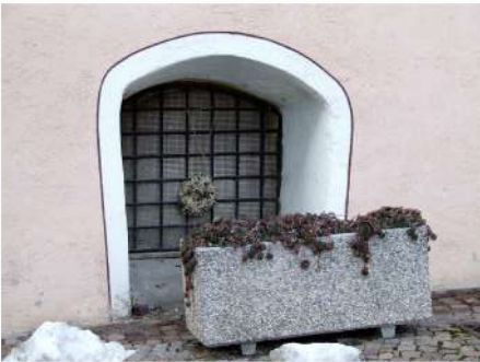
5. Foro ad orco sul fronte Sud
