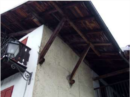
4. Dettaglio struttura di sostegno della copertura
