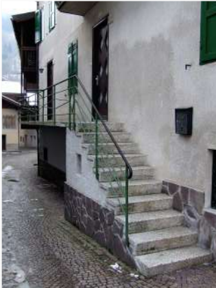
8. Scala in c.a. sul fronte Sud
