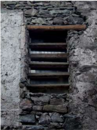
3. Finestra del fienile sul fronte Ovest
