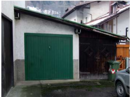
4. Garage coperto addossato al fronte Nord
