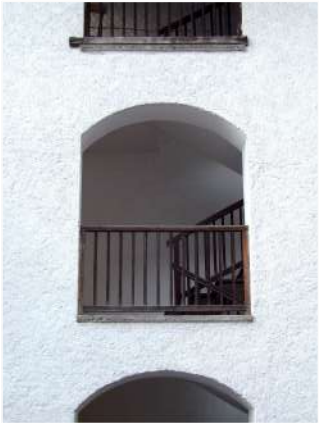
6. Dettaglio foro del vano scala
