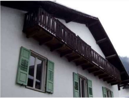
4. Dettaglio del balcone in legno sul fronte Sud
