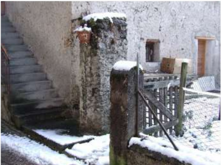
4. Vecchia porzione muraria a Nord-Ovest
