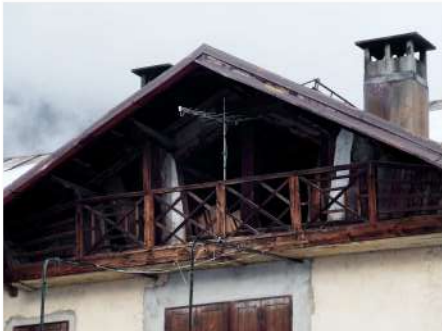
6. Dettaglio timpano e parapetto su prospetto Sud
