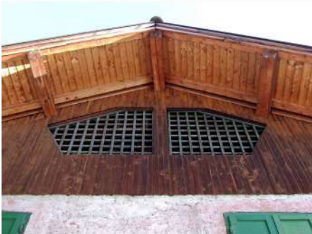
6. Dettaglio del tamponamento grigliato sul fronte Ovest
