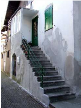
6. Scala in c.a. sul fronte Nord
