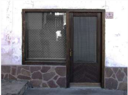
5. Ingresso di esercizio commerciale dismesso
