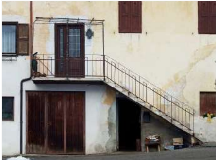
5. Scala in c.a. sul fronte Sud
