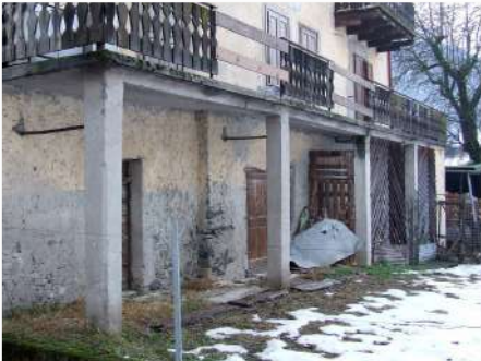
7. Porticato in c.a. sul fronte Ovest
