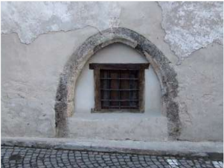
4. Dettaglio dell'arco in pietra ogivale sul fronte Ovest
