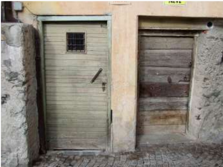
7. Portoni tradizionali in legno al piano terra
