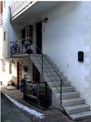
8. Scala di accesso sul fronte Est
