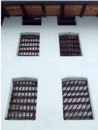
10. Dettaglio dei fori sul fronte Sud
