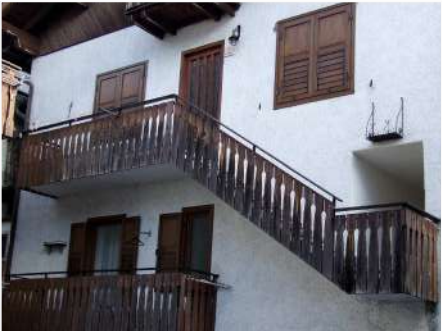
3. Scala esterna e balconi sul fronte Ovest
