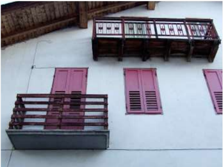
4. Parapetti sul fronte Ovest
