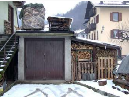
5. Garage e legnaia addossati al fronte orientale
