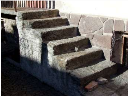
9. Scala in pietra sul fronte Sud
