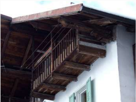
4. Dettaglio del ballatoio sul fronte Sud
