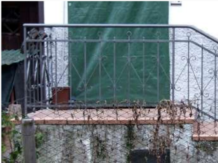
6. Scala di accesso in c.a. con parapetto metallico
