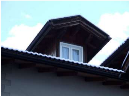
5. Abbaino sulla falda Ovest
