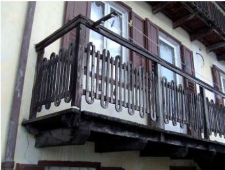
5. Parapetto sul fronte Sud
