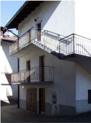
3. Balconi in c.a. con parapetti in metallo
