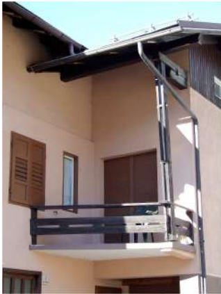
7. Balcone sul fronte Ovest
