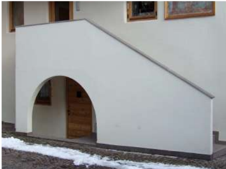
5. Volume della scala di accesso sul fronte Ovest
