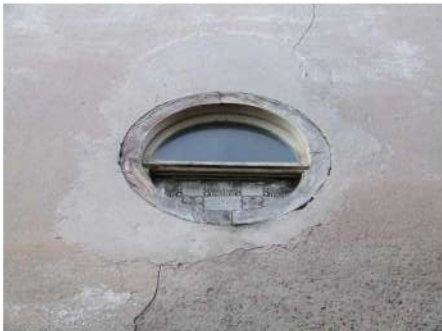
9. Dettaglio foro circolare sul fronte Est
