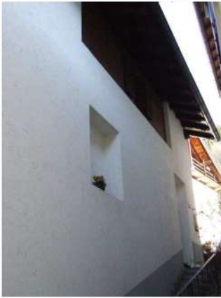
4. Dettaglio del prospetto Sud
