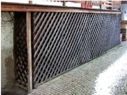
4. Legnaia con tamponamento grigliato sul fronte Est
