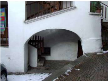
11. Dettaglio del portico alla base del corpo scala
