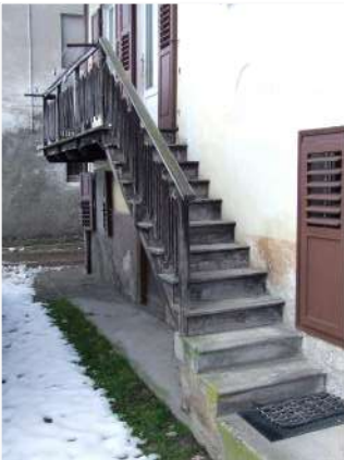
8. Scala in legno sul fronte Sud
