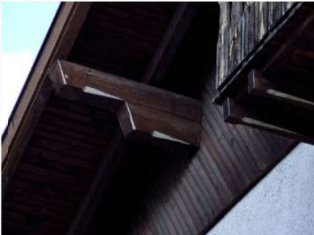
5. Tamponamento ligneo dei timpani
