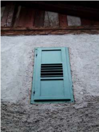
7. Dettaglio anta ad oscuro
