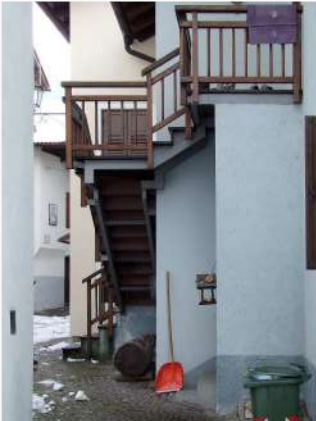
6. Dettaglio scala esterna
