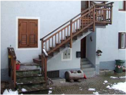
4. Scala esterna sul fronte Est
