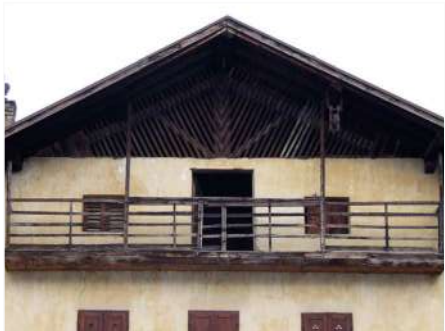
8. Dettaglio timpano e parapetto su prospetto Sud
