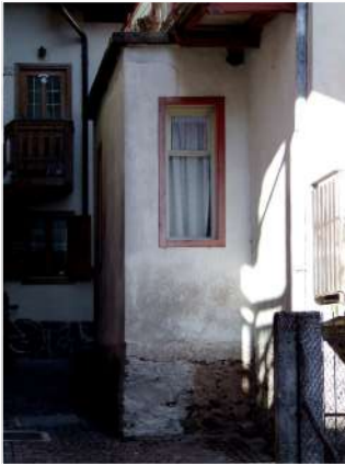
5. Volume aggetante sul fronte Ovest
