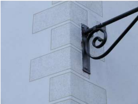
6. Dettaglio del finto bugnato
