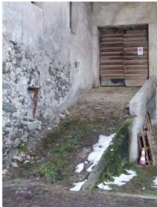
11. Dettaglio portile sul fronte Nord
