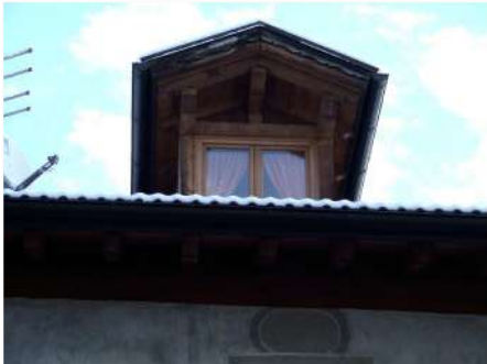
5. Abbaino sulla falda Ovest
