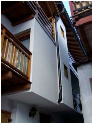
10. Volumi aggettanti fronte Est
