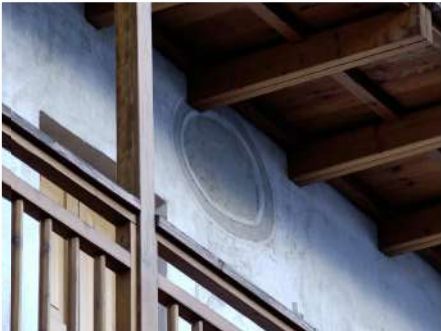
6. Vecchi fori circolari sottogronda tamponati
