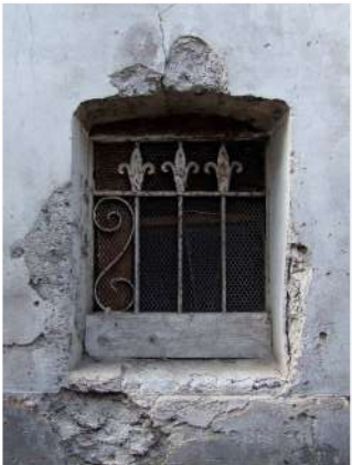
12. Dettaglio Inferriate In ferro battuto
