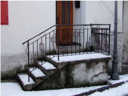
6. Scala di accesso in c.a. sul fronte Nord
