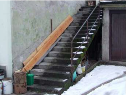
12. Scala in c.a. sul fronte Est
