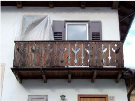
5. Dettaglio del balcone sul fronte Ovest
