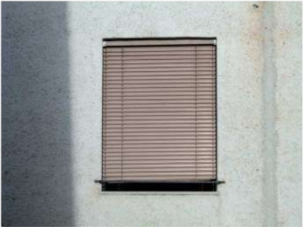
6. Dettaglio del frangisole sui fori del corpo scala
