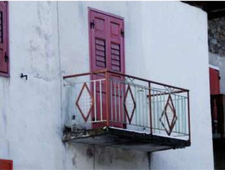
8. Balcone in c.a. con parapetto in metallo
