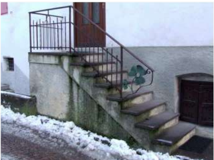
10. Scala di accesso in c.a. sul fronte Ovest
