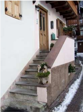
3. Scala in pietra sul fronte Sud
