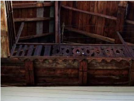
3. Dettaglio del Ballatoio sul fronte Ovest
