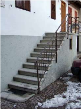
8. Scala in c.a. sul fronte Ovest
