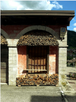
4. Dettaglio dei fori finestra con inferriata
