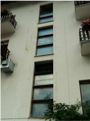
4. Dettaglio della vetrata del giroscale
