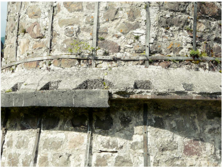
5. Dettaglio del cordolo perimetrale in c.a.
