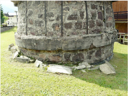
2. Dettaglio del basamento in pietra
