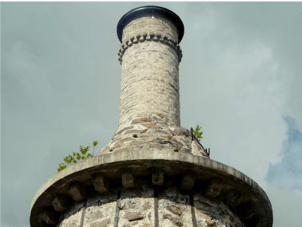
3. Dettaglio del comignolo in muratura
