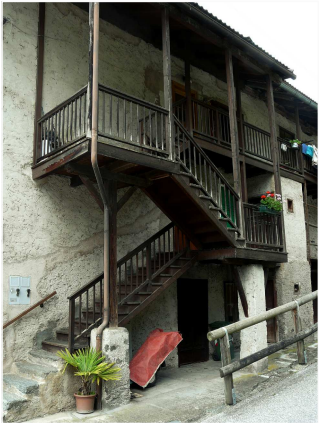
5. Scala in legno sul fronte Est
