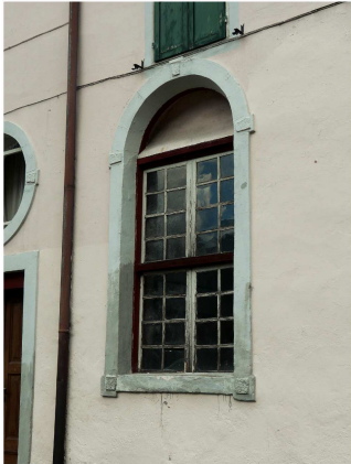
11. Finestra ad arco sul fronte Est
