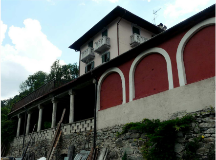
5. Volume dei garage e dell'interrato sul fronte Est
