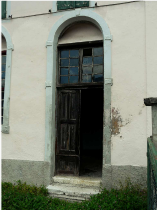
9. Porta di Ingresso ad arco
