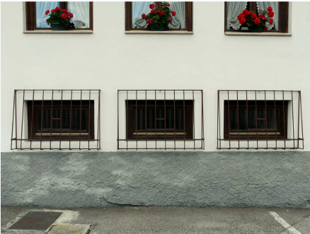
5. Dettaglio delle finestre del piano seminterrato
