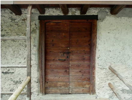
6. Dettaglio del portone del fienile sul fronte Est
