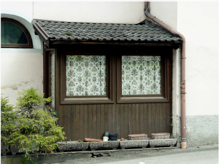
15. Superfetazione lignea sul fronte Ovest
