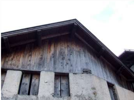
5. Tamponamento in assito verticale del timpano
