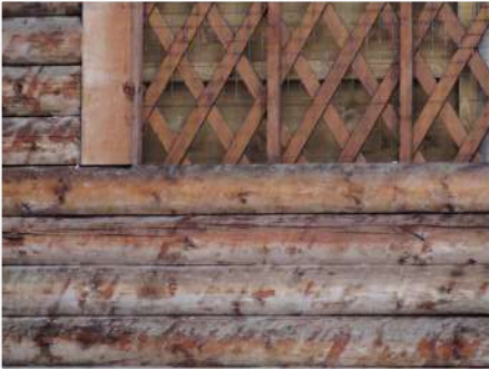
12. Struttura portante in block-bau sul fronte Ovest
