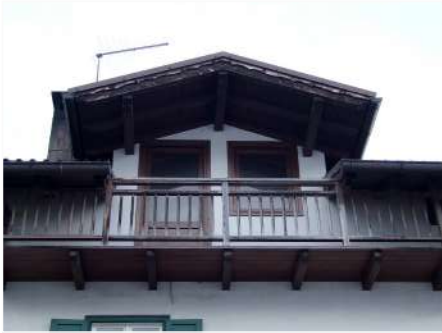
6. Abbaino sul fronte Ovest
