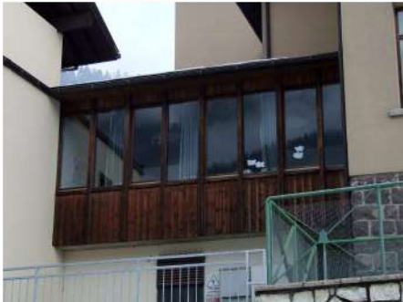
5. Rivestimento ligneo sul fronte Ovest
