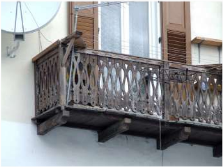
5. Dettaglio parapetto sul fronte Sud
