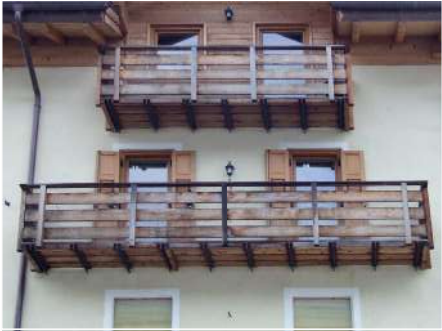
4. Dettaglio dei parapetti provvisori
