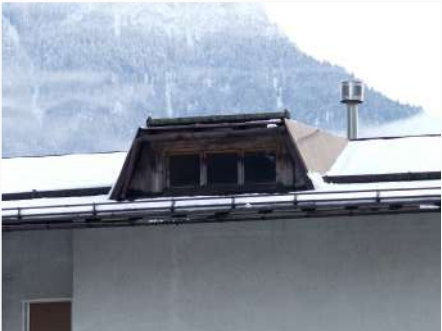
4. Dettaglio dell'abbaino sulla falda settentrionale
