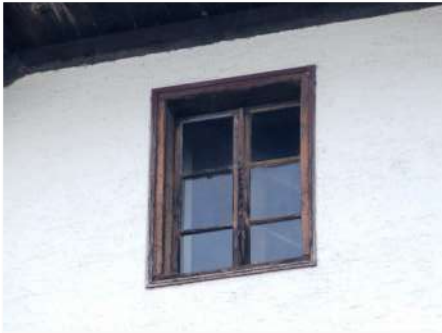
4. Dettaglio serramento tradizionale in legno
