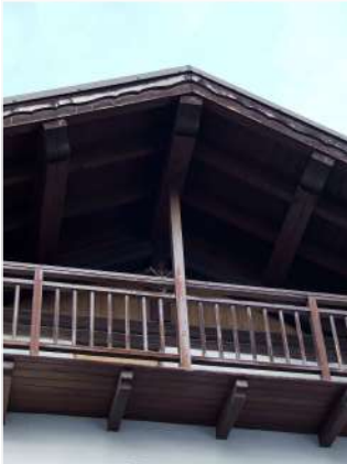
9. Timpano sul fronte Sud
