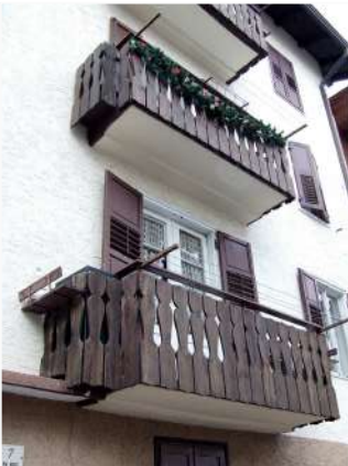
6. Balconi sul fronte Sud
