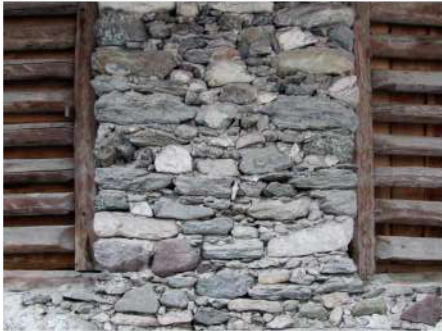
13. Dettaglio della muratura in pietra a vista
