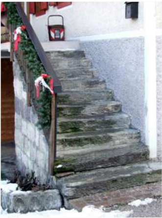
7. Scala in pietra locale sul fronte Sud
