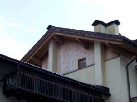
5. Tamponamento del timpano Nord
