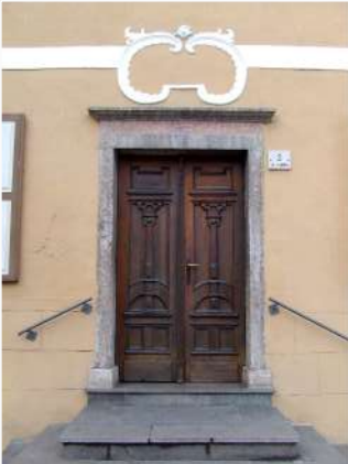
7. Portone di Ingresso a piano terra
