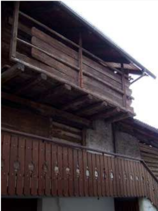
10. Ballatoio in legno sul fronte Est
