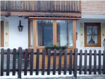
4. Dettaglio bussola sul fronte Ovest
