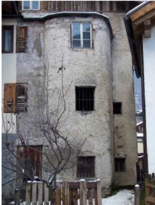
10. Volume aggettante sul fronte Ovest
