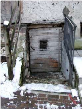
8. Ingresso del piano interrato
