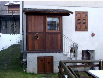
9. Bussola in legno sul fronte Ovest
