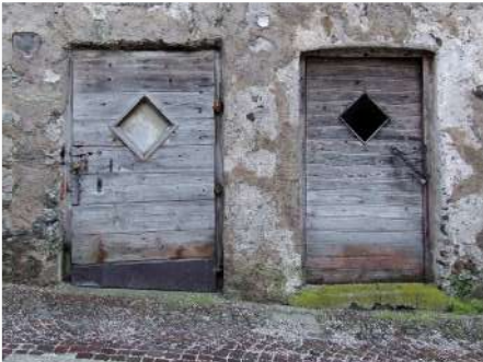
6. Portoni di ingresso tradizionali sul fronte Nord
