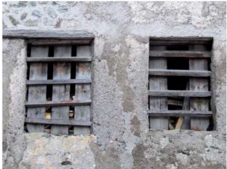
4. Tamponamento dei fori sul fronte Nord
