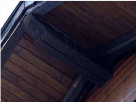
5. Dettaglio della struttura di copertura (1925)
