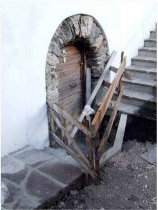
5. Cornice in pietra sul fronte Sud
