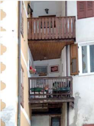
3. Ballatoi sul fronte Ovest
