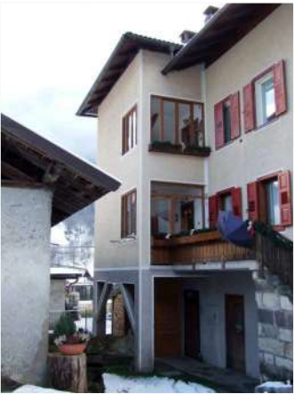
8. Volume del vano scala sul fronte Sud
