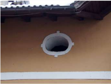
5. Dettaglio foro circolare sottogronda
