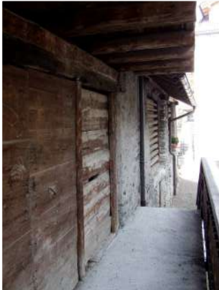
11. Ingresso del fienile sul fronte Est
