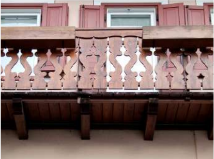
4. Dettaglio parapetto sul fronte Sud
