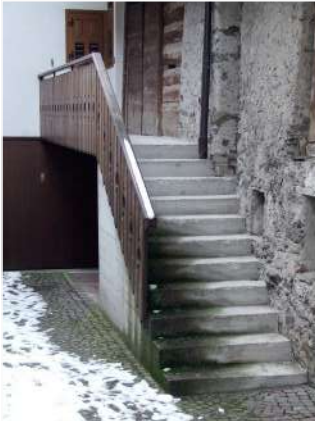
9. Scala in c.a. sul fronte Est
