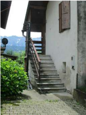
3. Dettaglio della scala sul fronte Est
