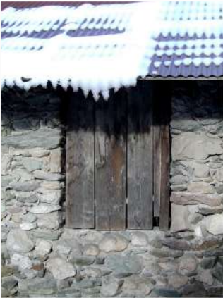
4. Tamponamento ligneo del fienile
