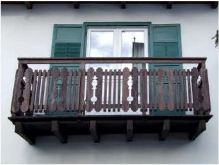
5. Dettaglio del balcone sul fronte Sud
