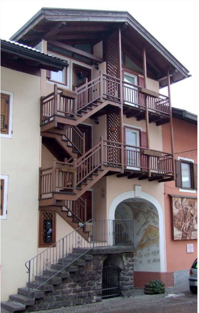
3. Scala esterna sul fronte Nord
