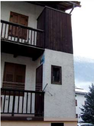
8. Volume In aggetto sul fronte Est
