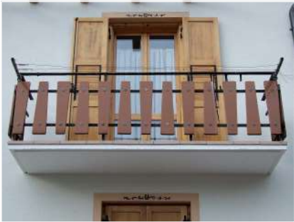
4. Dettaglio parapetti in metallo
