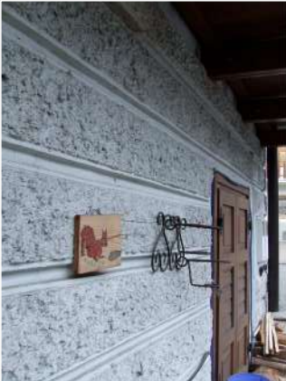
7. Finitura piano terra del fronte Sud
