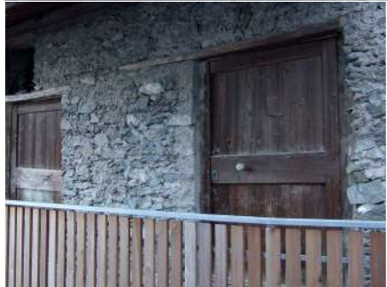
3. Portoni in legno di accesso al fienile
