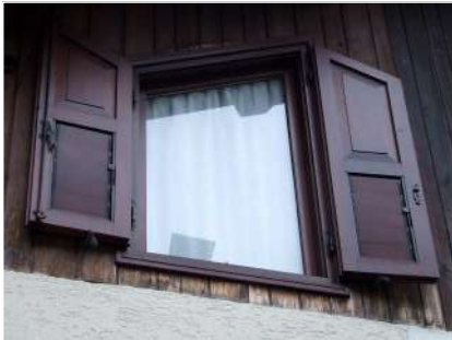
5. Finestra trapezoidale del timpano a Nord-Est
