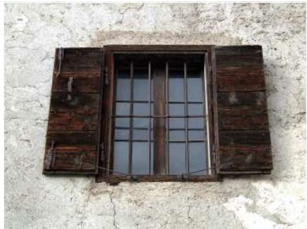
4. Serramento tradizionale sul fronte Sud
