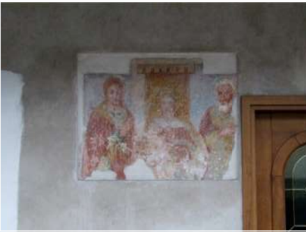
4. Pittura muraria sul fronte Sud
