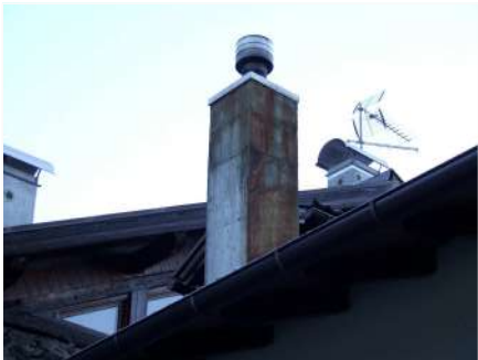
5. Dettaglio del camino in c.a.
