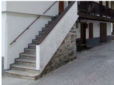
5. Scala e ballatoio sul fronte Est
