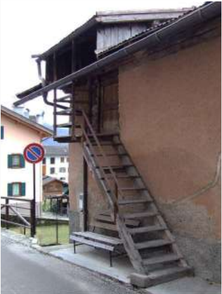
6. Scala in legno sul fronte Est
