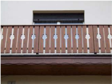
5. Dettaglio parapetto ed avvolgibile sul fronte Ovest
