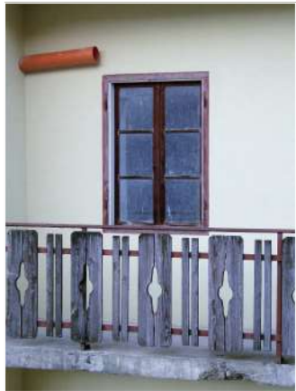
3. Dettaglio del parapetto sul fronte Sud
