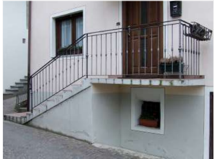
4. Scala di accesso sul fronte Ovest
