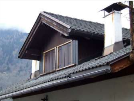
6. Abbaino sulla falda Sud
