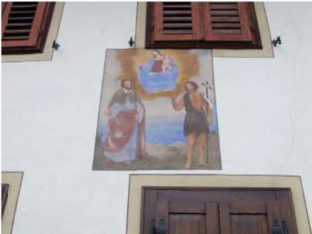
7. Pittura muraria sul fronte Sud
