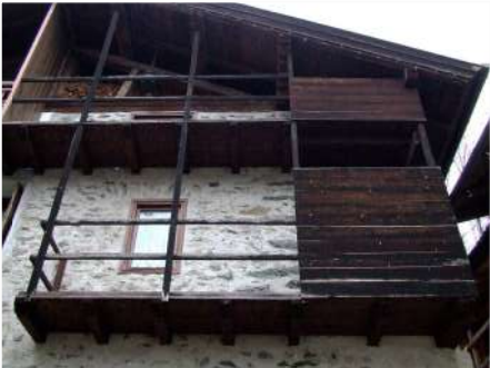
6. Ballatoio e tamponamento ligneo su fronte principale
