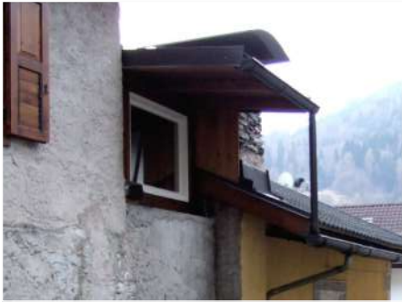
5. Dettaglio copertura su fronte Nord
