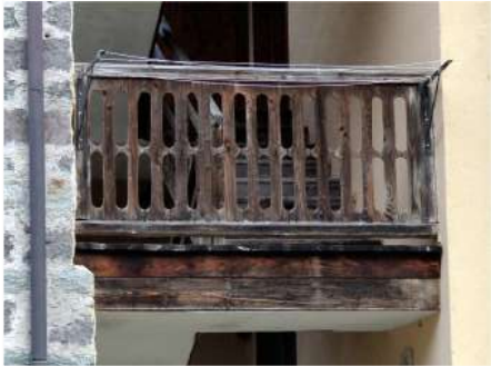
4. Dettaglio del parapetto scala
