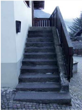
7. Scala in pietra sul fronte Ovest
