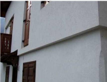
7. Dettaglio dell'isolamento a cappotto
