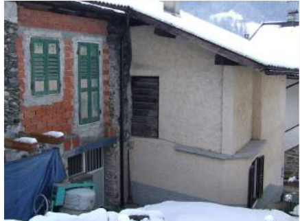
7. Vista del fronte Nord con muratura in laterizio a vista
