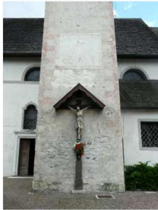
4. Dettaglio della base del campanile
