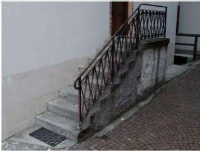
5. Dettaglio scala di accesso sul fronte Est
