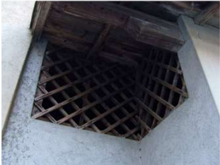
4. Tamponamento in grigliato ligneo sul fronte Nord
