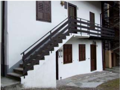
4. Scala e ballatoio sul fronte Sud-Ovest
