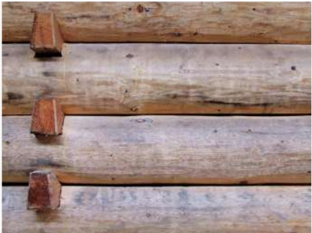
5. Struttura di elevazione in block- bau
