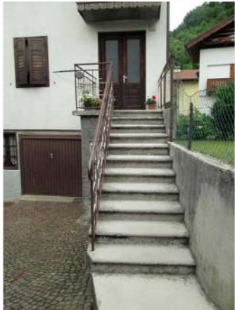
4. Scala esterna in c.a. sul fronte Sud
