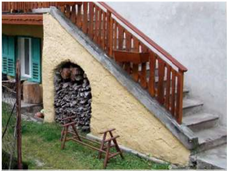
3. Scala di accesso sul fronte Ovest
