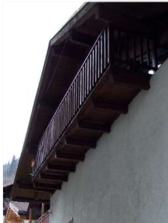
2. Dettaglio del ballatoio sul fronte Ovest
