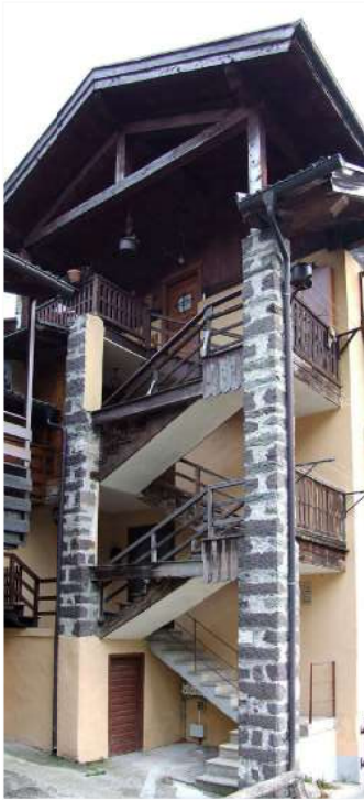
7. Dettaglio del corpo scala a Nord
