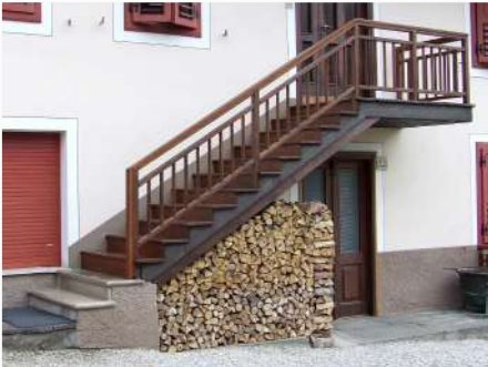
7. Scala in legno sul fronte Ovest
