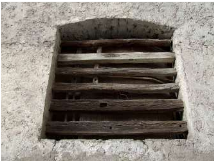
5. Foro tradizionale del fienile sul fronte Sud
