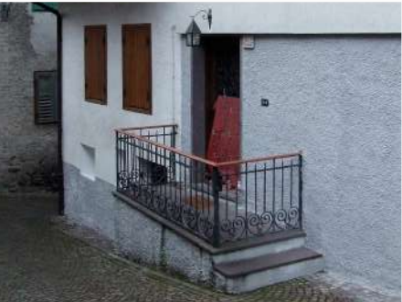
6. Parapetto in metallo sul fronte Sud
