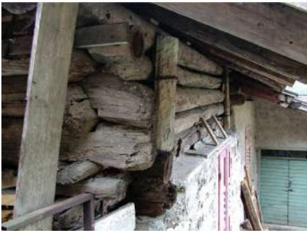
5. Dettaglio della struttura in block-bau
