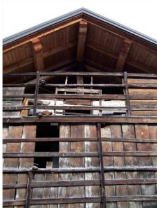
8. Aggetto ligneo sul fronte Ovest
