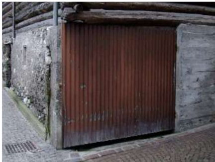
7. Tamponamento provvisorio in lamiera
