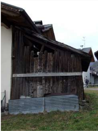
6. Superfetazione sul fronte Est
