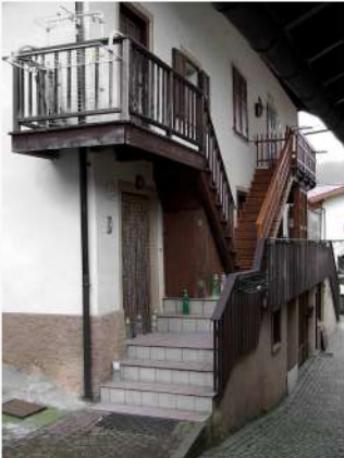
8. Scale e ballatoi sul fronte Ovest
