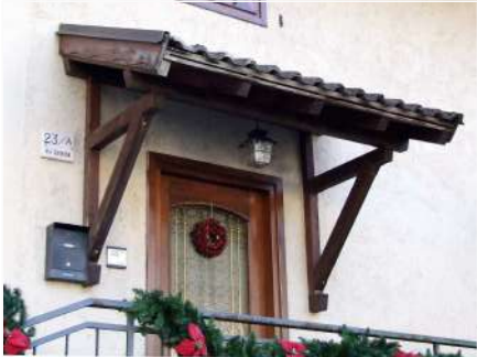
5. Copertura dell' ingresso sul fronte Nord
