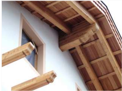
3. Dettaglio sporto di gronda in legno di larice
