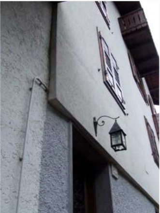
5. Dettaglio della coibentazione a cappotto
