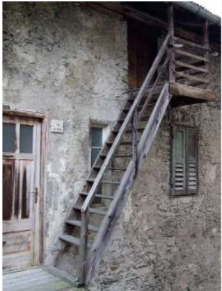
5. Scala in legno sul fronte Ovest
