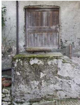
7. Portone del fienile sul fronte Nord
