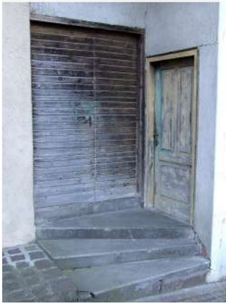
6. Portone in legno sul fronte Nord
