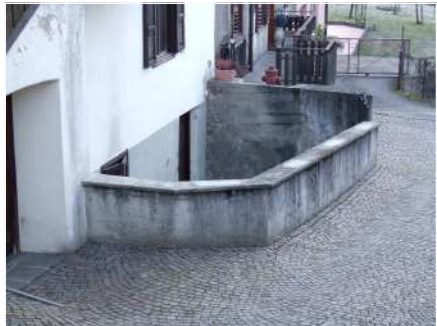
4. Muretto di protezione sul fronte Ovest
