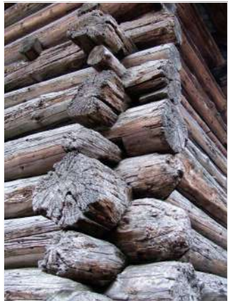
5. Dettaglio della struttura in block-bau
