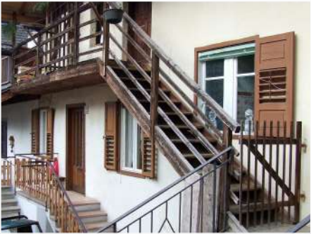
3. Scala e ballatoio ligneo su prospetto Sud
