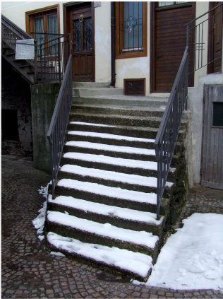
2. Scala in c.a. sul fronte Est
