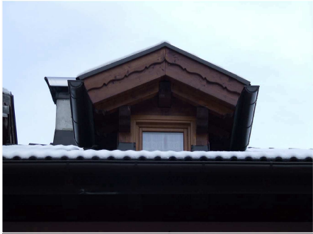
4. Abbaino sulla falda Sud
