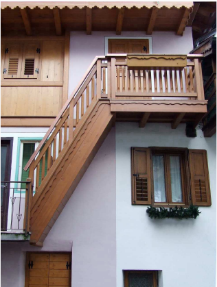
8. Scala esterna sul fronte Ovest
