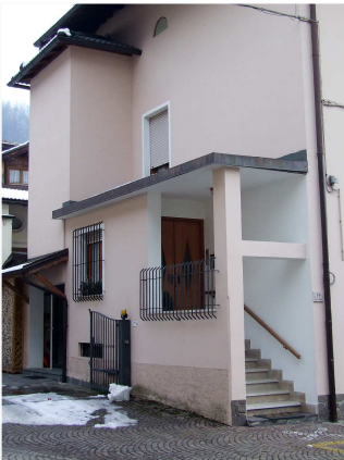
8. Volumi aggettanti sul fronte Nord
