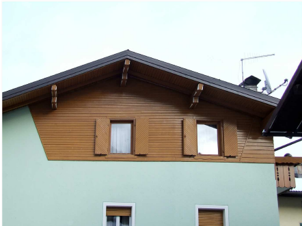
5. Tamponamento ligneo del timpano occidentale
