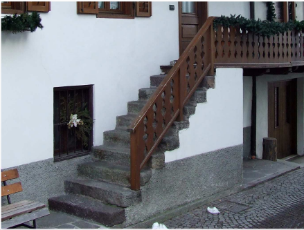
3. Scala in pietra sul fronte Ovest
