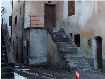
4. Scala in pietra locale sul fronte Ovest
