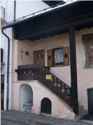
9. Scala di accesso sul fronte Est
