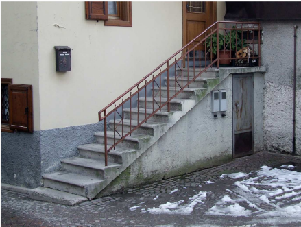
5. Dettaglio scale in C.A. sul fronte Nord
