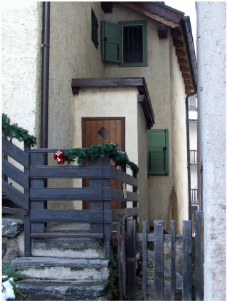
5. Volumi aggettanti sul fronte Nord
