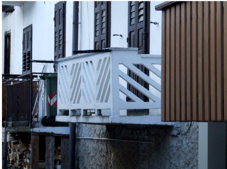
6. Balconcino realizzato in c.a. sul fronte Ovest
