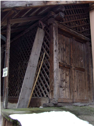
4. Tamponamento grigliato sul fronte Sud
