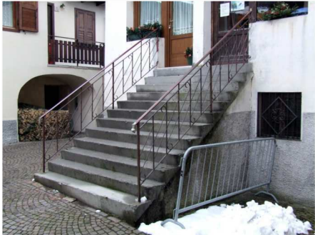
6. Scalinata di accesso in c.a.
