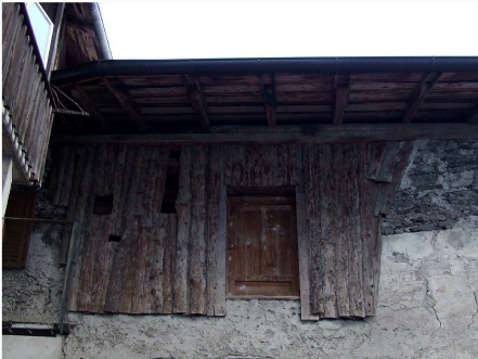
5. Tamponamento ligneo sul fronte Nord
