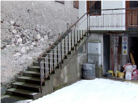
6. Scala in c.a. sul fronte Est
