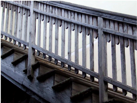
4. Dettaglio parapetto scala in legno sul fronte Est
