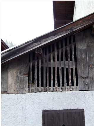
5. Tamponamento ligneo del timpano
