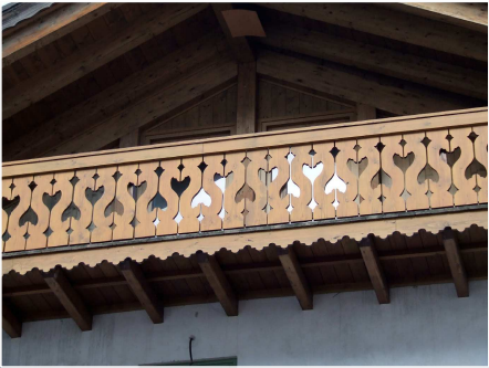
3. Dettaglio del parapetto ad Ovest
