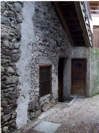
9. Muratura in pietra a vista sul fronte Est
