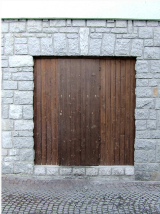
8. Portone In legno del garage
