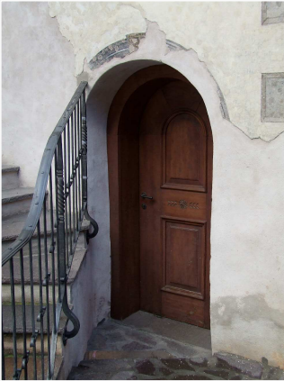
6. Ingresso piano terra
