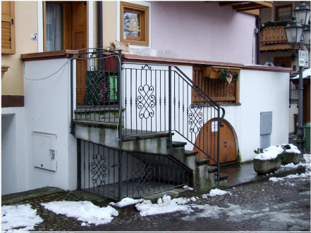
6. Volume aggettante con scala in c.a. sul fronte Nord
