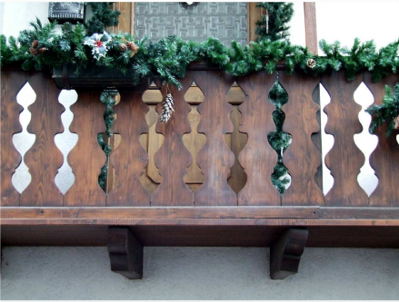
4. Dettaglio parapetto in legno sul fronte Ovest
