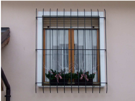
6. Griglia antieffrazione al piano terra
