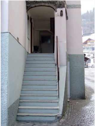
7. Scalinata di accesso sul fronte Est
