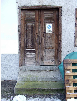
3. Dettaglio del portone di ingresso
