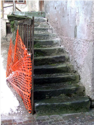
7. Scala in pietra locale sul fronte Nord
