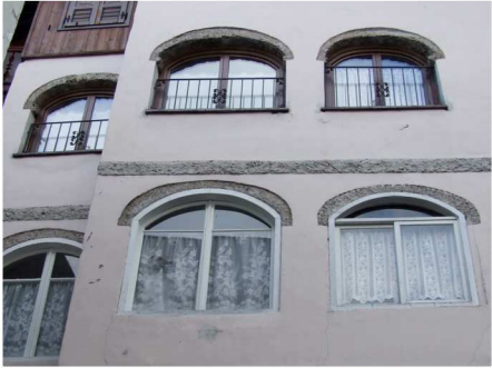
10. Fineste ad arco sul fronte Est
