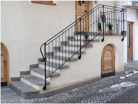
5. Scala esterna sul fronte Est
