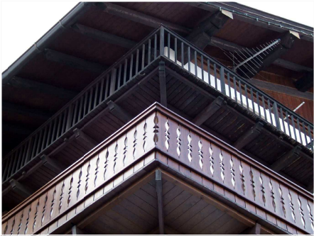
4. Dettaglio dei balconi all'angolo Sud-Ovest
