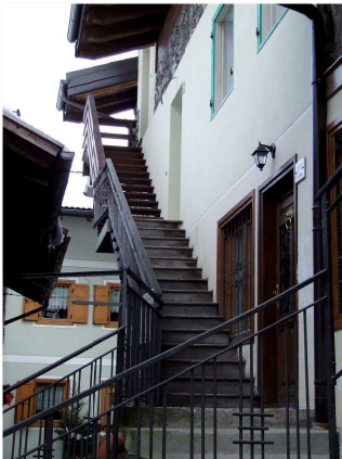
7. Scala in legno sul fronte Est
