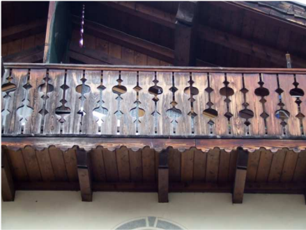
11. Dettaglio poggiolo con parapetto tradizionale
