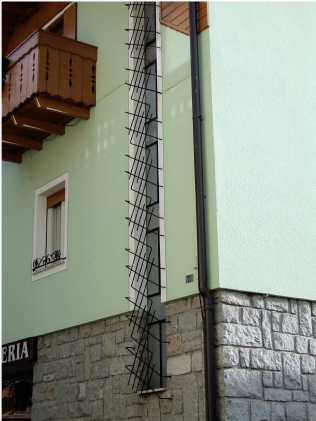
7. Finestra del vano scala sul fronte Nord
