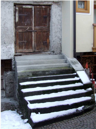
5. Scala in c.a. sul fronte Est
