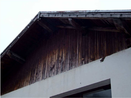
4. Tamponamento in assito verticale del timpano Nord
