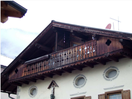
7. Dettaglio del timpano ligneo
