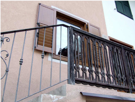
6. Dettaglio dei parapetti sul fronte Est
