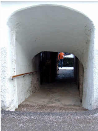
7. Portico comunicante con Il retro
