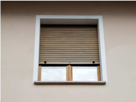
5. Dettaglio avvolgibile in pvc
