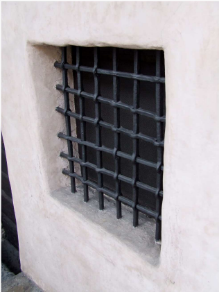
7. Dettaglio griglia in ferro battuto
