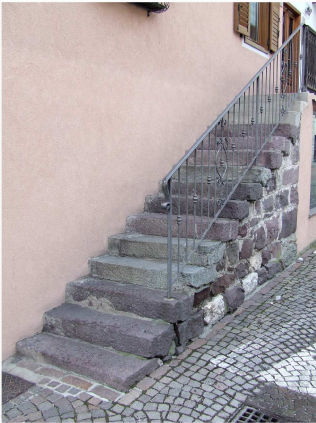
4. Scala in pietra sul fronte Est
