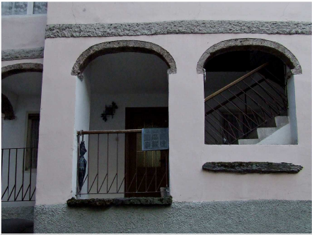
6. Dettaglio del vano scala sul fronte Est
