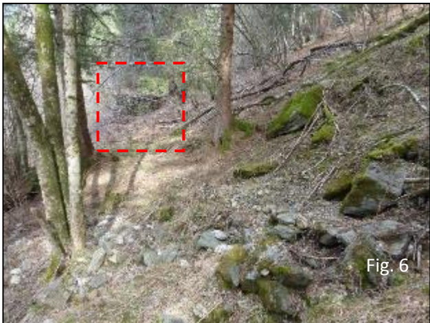
Fig.6: Edificio n.12 da Sud Est.
