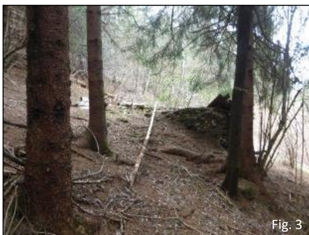
Fig.3: Edificio n.11, da Nord/Nord Ovest
