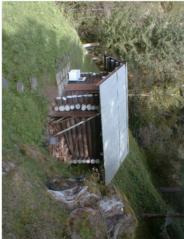
Altra inquadratura del manufatto in legno con struttura a blockbau.
