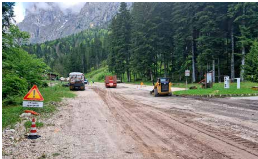
Lavori di asfaltatura su strade forestali Foto Archivio comunale
